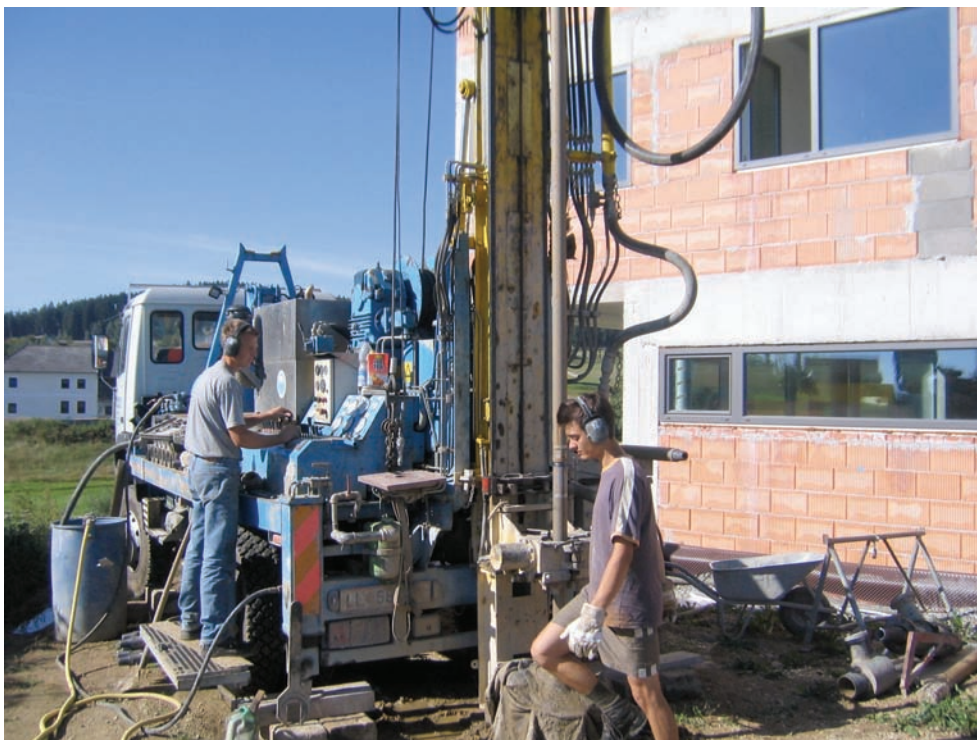
Bild unten: Sondenbohrung
